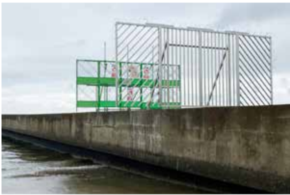
△設置された立入禁止フェンス
